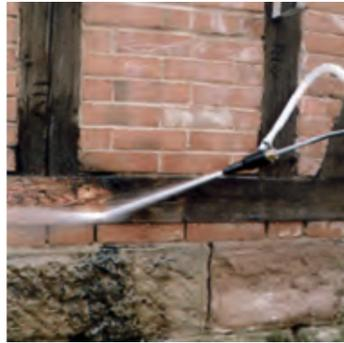
Устройство для гидроабразивной чистки, легко устанавливаемое на струйной трубке аппарата высокого давления Kärcher, обеспечивает всасывание абразивного средства и его добавку в струю воды, приобретающую мощный абразивный эффект. Обработка такой струей гарантирует эффективное удаление ржавчины, окислы, старых лакокрасочных покрытий, а также граффити.
