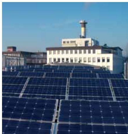
Солнечная электростанция в Виннендене
