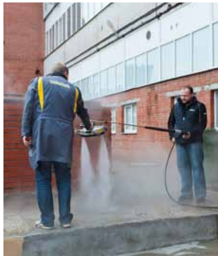
Очистка поверхности с помощью FRV 30 Me
