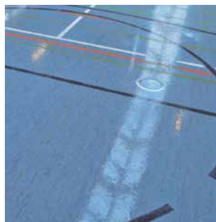
Напольное покрытие после нанесения защитного слоя.
